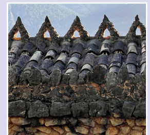
SA CAPELLETA DE SÓLLER Arreglar teulades de la capelleta de la Mare de Déu de Lourdes
