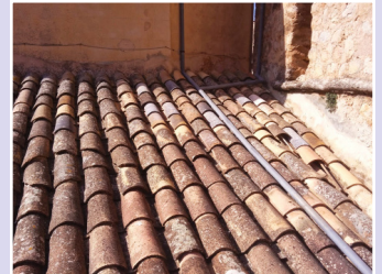
PARRÒQUIA DE FORNALUTX Reparació de les teulades.
